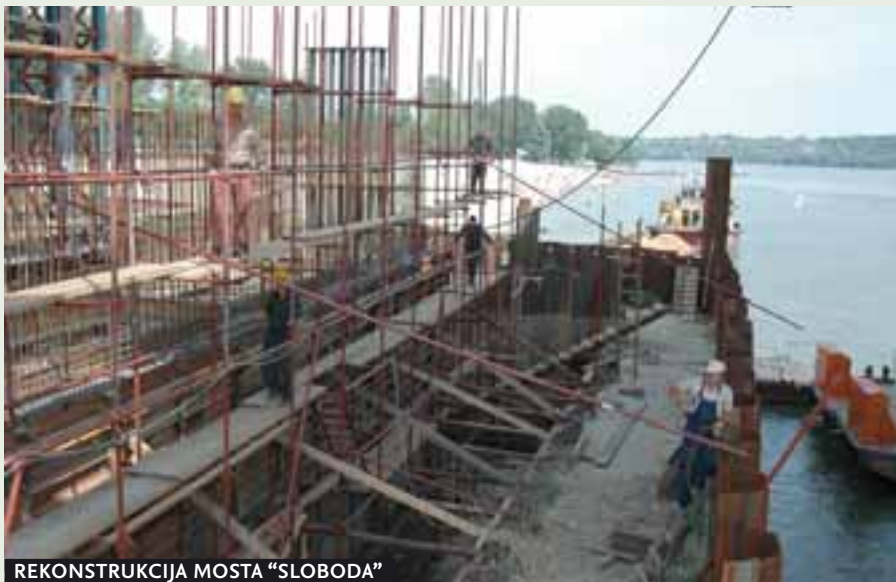
REKONSTRUKCIJA MOSTA "SLOBODA"
